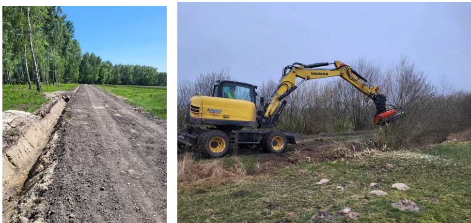
Foto: Utwardzona droga i odkrzaczanie poboczy drogi gminnej w Konarzewie
