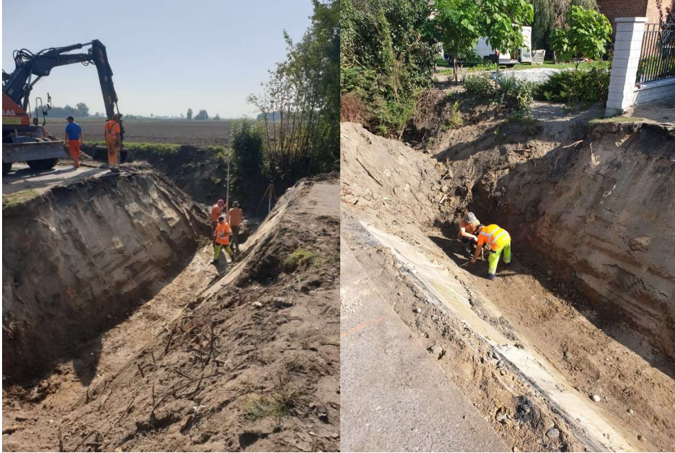
Foto: Remont przepustu pod drogą gminną w Goślubiu II
