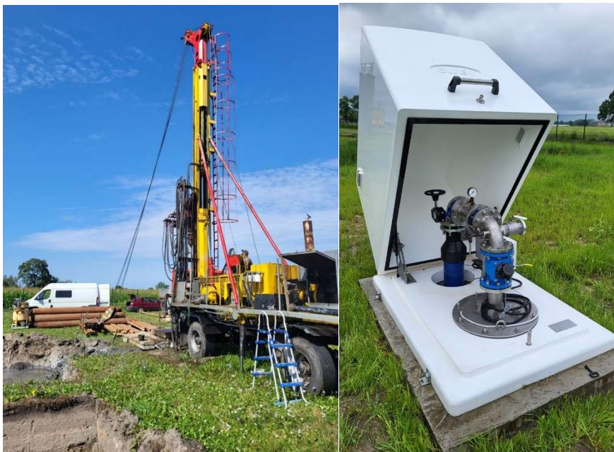
Foto: Budowa oraz wykonana studnia głębinowa na SUW w Pokrzywnicy
