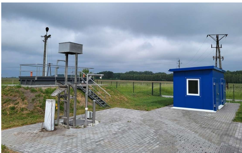
Foto: Przebudowana oczyszczalnia ścieków w Goślubiu Osadzie
