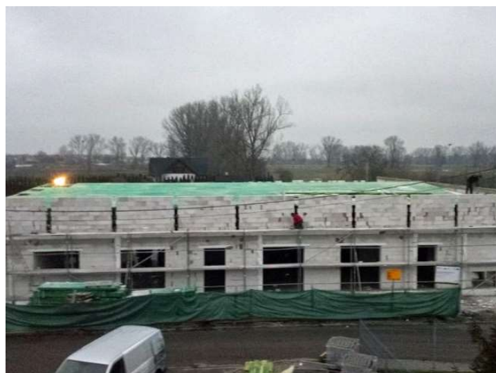
Foto: Budowa pasywnego budynku przedszkola w Piątku
