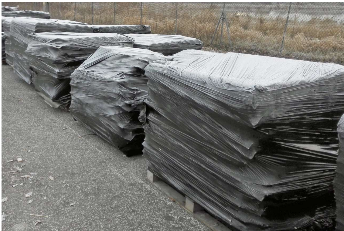
Przygotowane do utylizacji wyroby zawierające azbest usunięte z terenu Gminy Piątek
